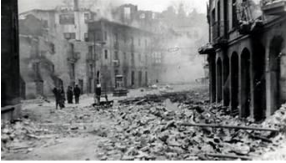
Vista del desastre ocasionado por el bombardeo.
