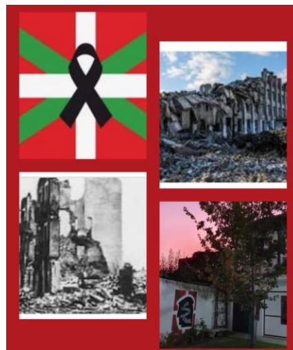
Imágenes de destrucción e impotencia.
